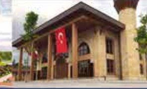
650 m 2 Hava Kaynaklı 64 kW Karaosmanoğlu Camii - Yuvacık/ Kocaeli
