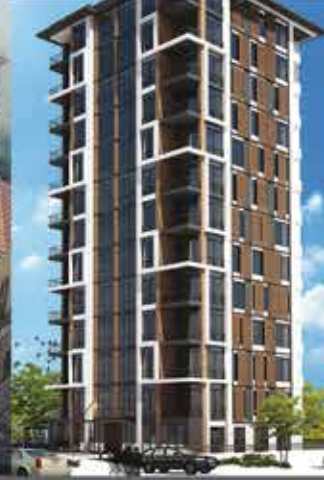
2300 m 2 Su Kaynaklı Isı Pompası 120 kW Residence - Kadıköy/İstanbul
