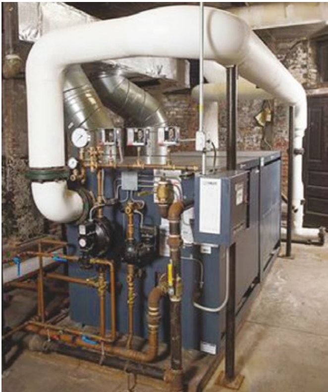
Mendota'nın kazan dairesindeki LGB-20 buhar kazanı.
