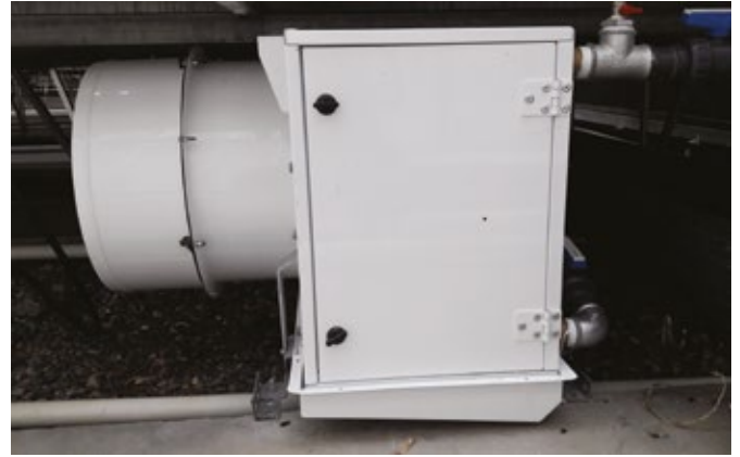
Özel alüminyum kasalı ve hava flanşlı soğutucu çalışması örneği.
