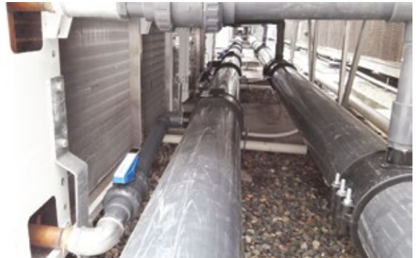
Özel taşıyıcı ayaklar ile kolay montaj. Paralel bağlantılı tesisatla tüm alana yayılan eşit sıcaklık uygulaması
