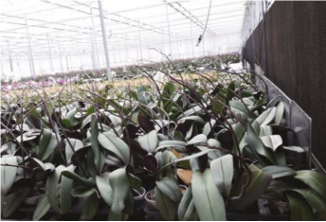
Giriş havasının neme doyurulması ile sağlanan iklimlendirme uygulamasına örnek. Petekli adyabatik soğutma sistemi
